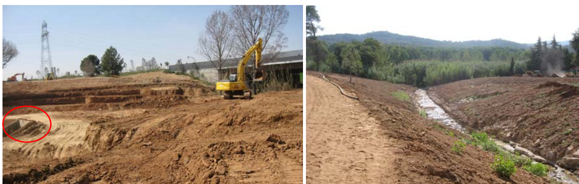
Figura 5 Remodelació topogràfica de la llera del torrent del Bosc. A la foto de l'esquerra (al fons) s'observa el viaducte de 30 m d'amplada i a l'esquerra encerclat en vermell, encara es pot veure el brocal de l'obra de drenatge preexistent abans de la seva demolició. En la foto de la dreta, es veu una vista general de la llera restituïda abans de dur a terme les revegetacions. Fotos: Consorci Urbanístic Centre Direccional.
