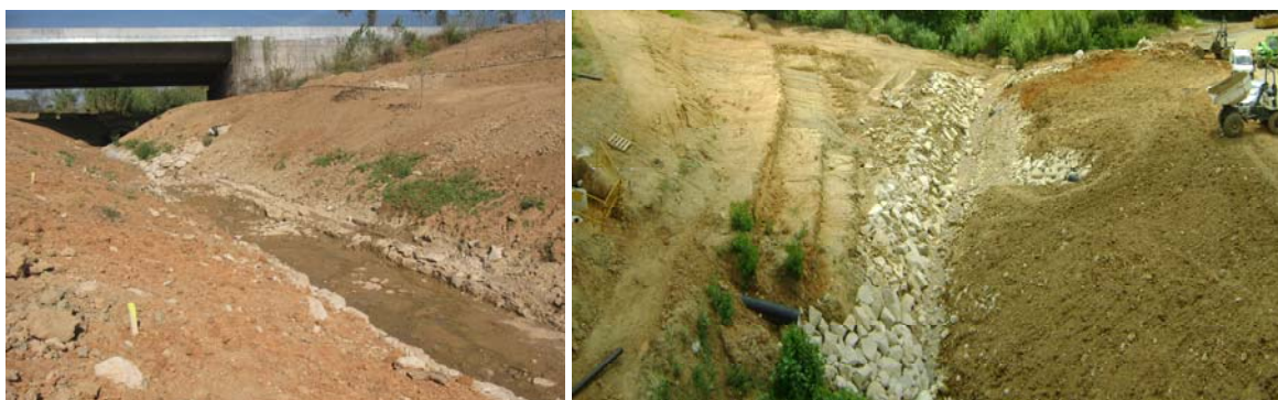
Figura 4 Llera restituïda del torrent del Bosc.. A la foto de l'esquerra estat de la llera restituïda sota el viaducte de la carretera BP-1413. En la foto de la dreta l'estat de la llera restituïda aigües avall del viaducte i abans de la seva aflüència a la riera de Sant Cugat. Fotos: Consorci Centre Direccional
