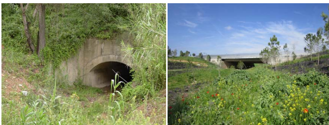
Figura 2 Carretera BP-1413 al torrent del Bosc. A la foto de l'esquerra (al fons) s'observa la volta de 3 m d'amplada existent abans de l'execució de les obres previstes en el projecte del Corredor Verd. A la dreta s'observa vista general del viaducte de 30 m d'amplada existent en l'actualitat. Fotos: Minuartia.
